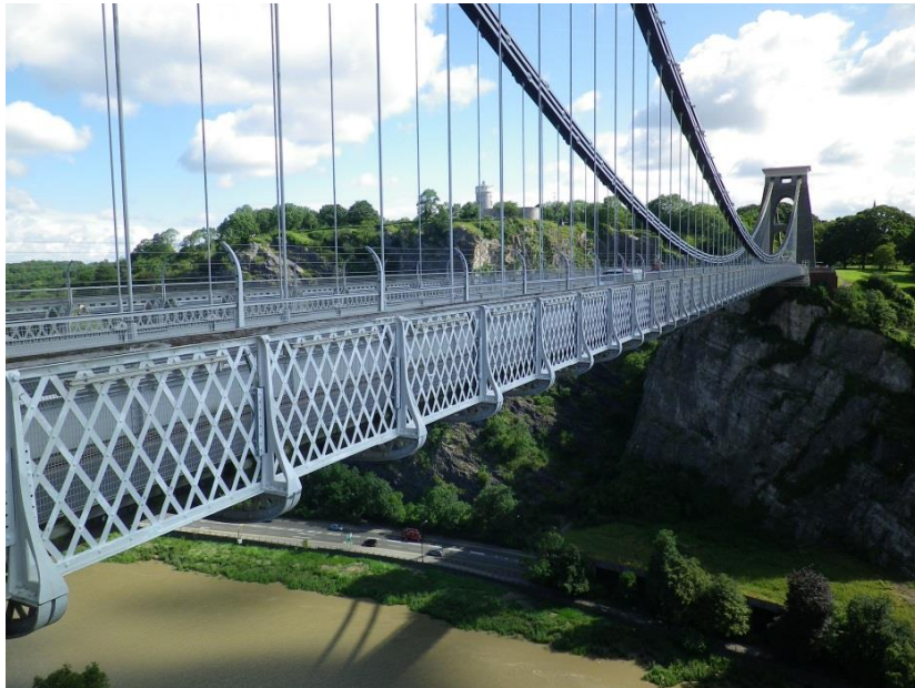
写真 1 : クリフトン吊橋(筆者が 2012 年に撮影)
