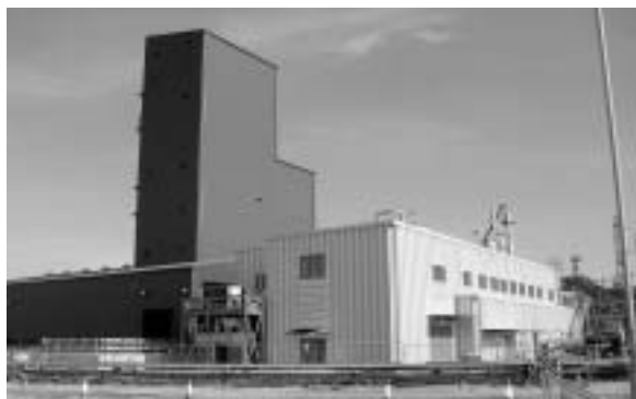
ハル工場全景
