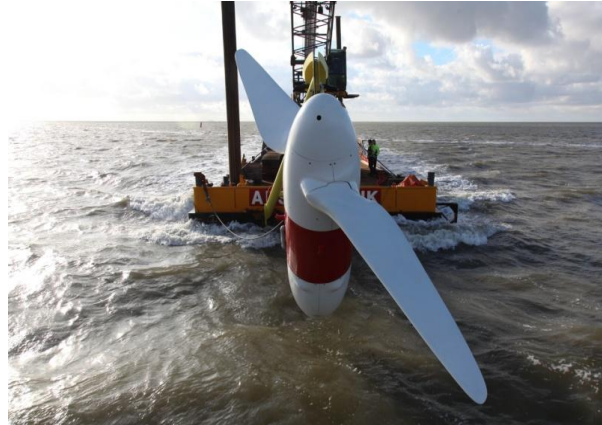
Tocado T100 installation (images courtesy of Tocardo).
